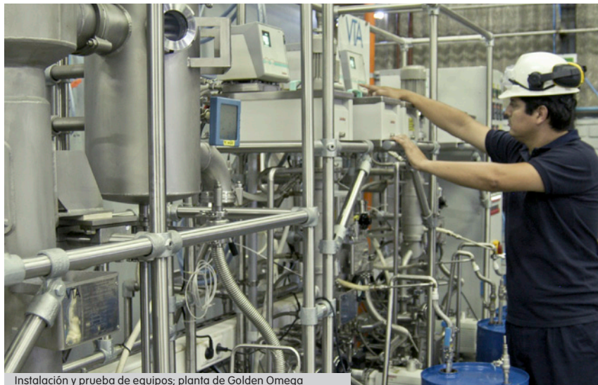
Instalación y prueba de equipos; planta de Golden Omega
