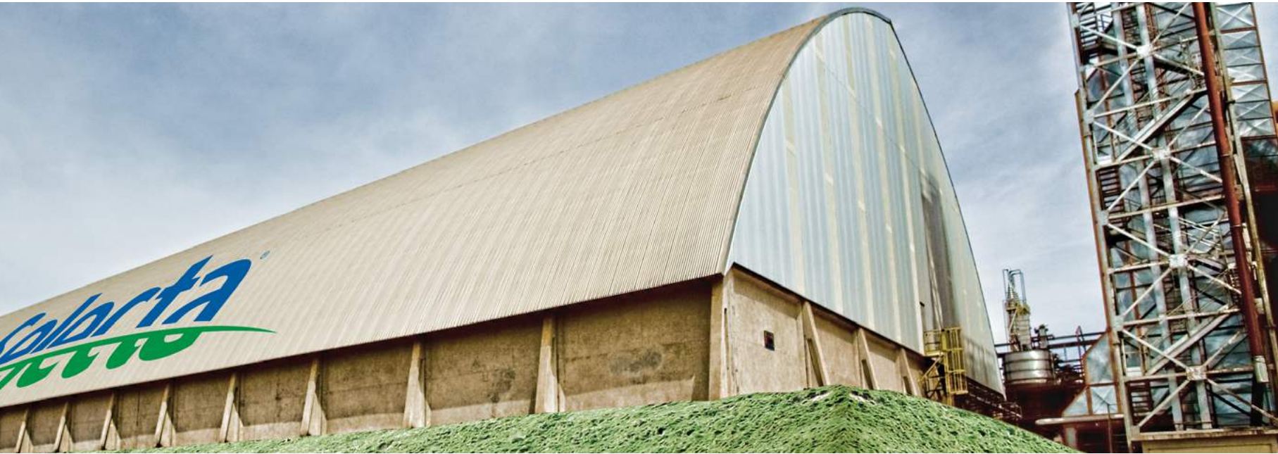
Galpón de almacenamiento de materia prima, Planta industrial Selecta, Brasil.
