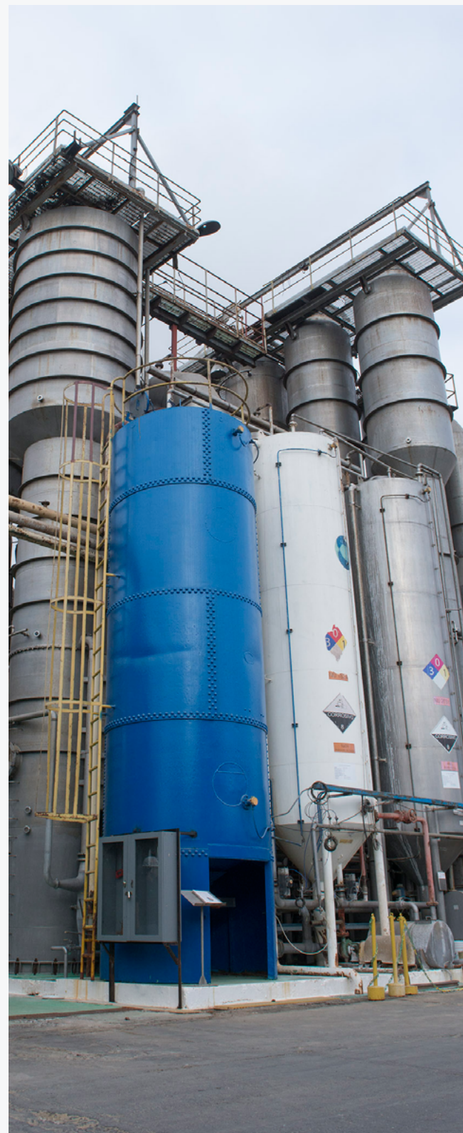
Evaporador en Planta industrial Iquique Sur de Corpesca S.A.
