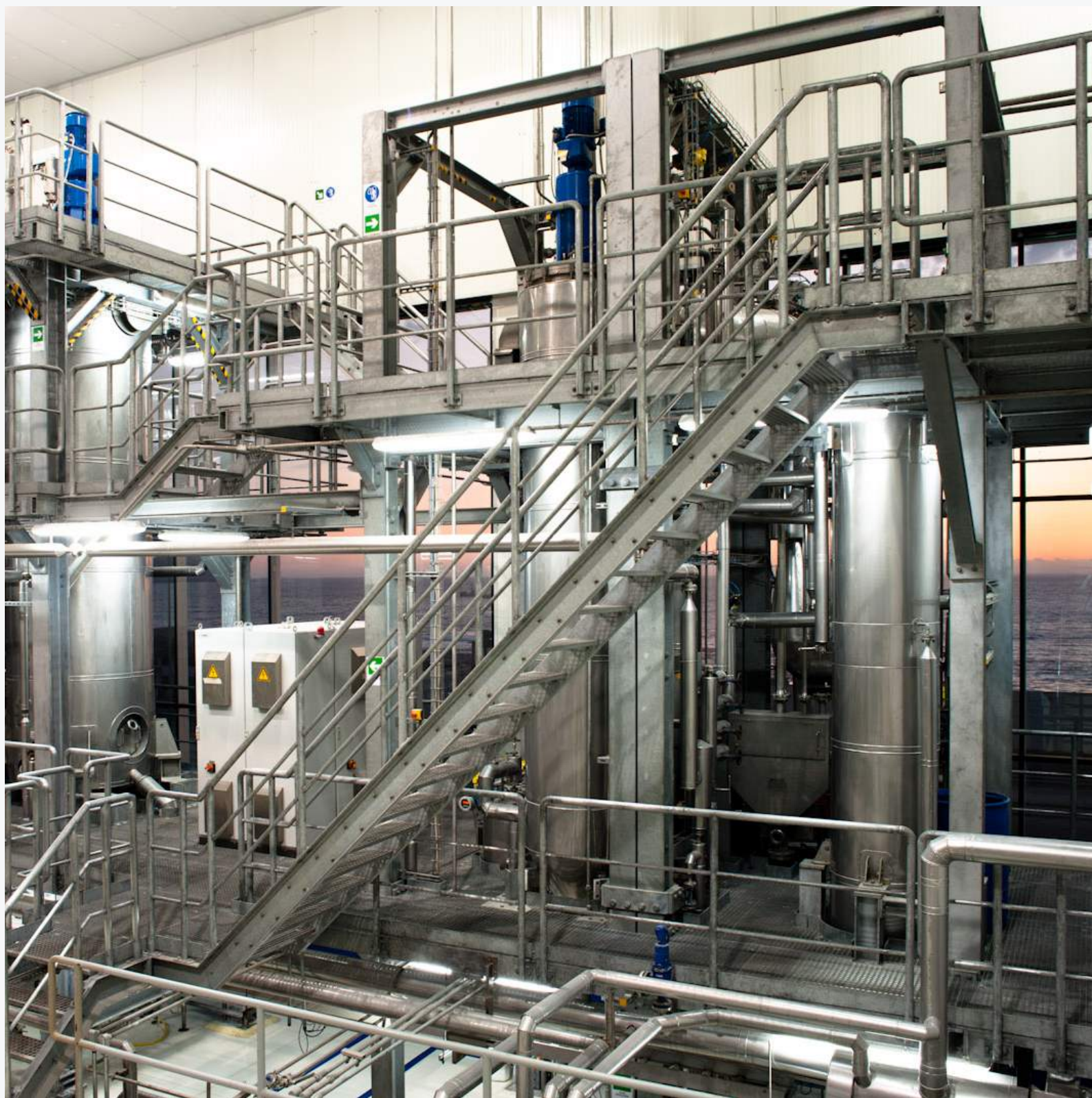
Instalaciones de Planta industrial de Golden Omega S.A. en Arica.
